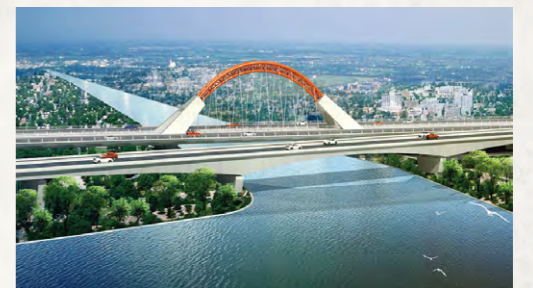
常州市高架二期（新运河大桥至广电路）工程
